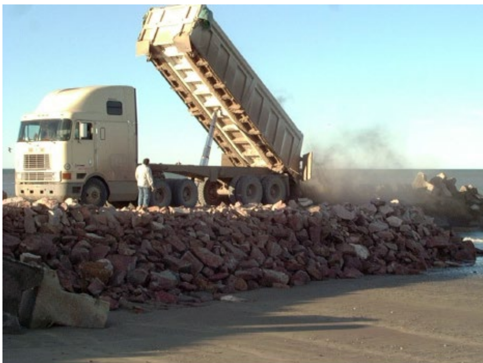
Fotografía 2 Construcción de enrocado por avance directo
