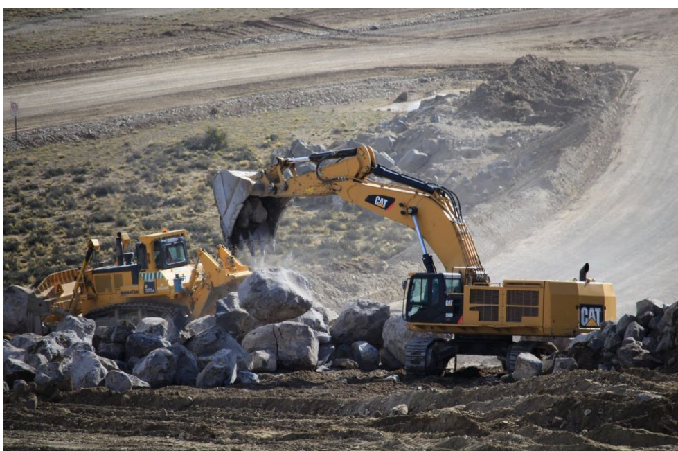
Fotografía 3 Colocación de rocas de gran tamaño
