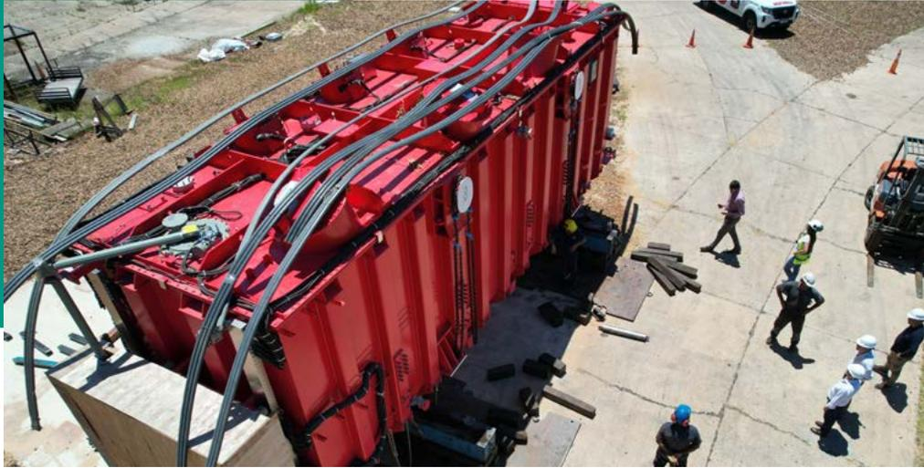
*Banco Trifásico marca Siemens 300 MVA en SGA en etapa de premontaje y luego montaje terminado.*
