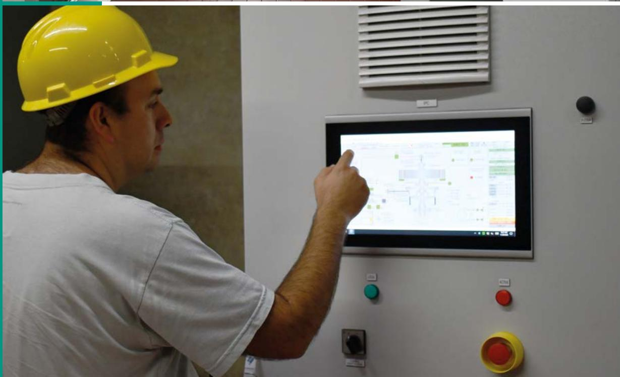
*Gabinete regulador de velocidad cerrado/abierto. Pantalla del SCADA y sistema de filtrado nuevo*
