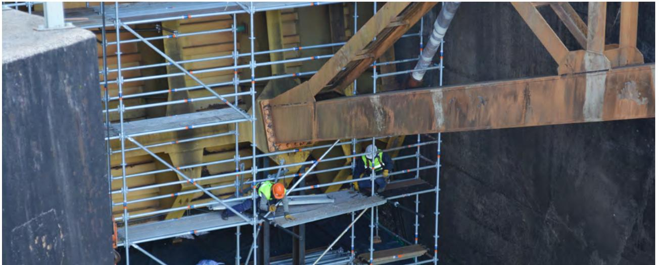
Foto 2: Armado de andamios sobre compuerta radial
