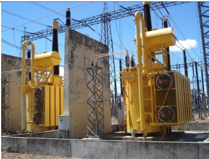
Fotografía 40: Reactores a retirar de la E.T. Salto Grande Argentina
