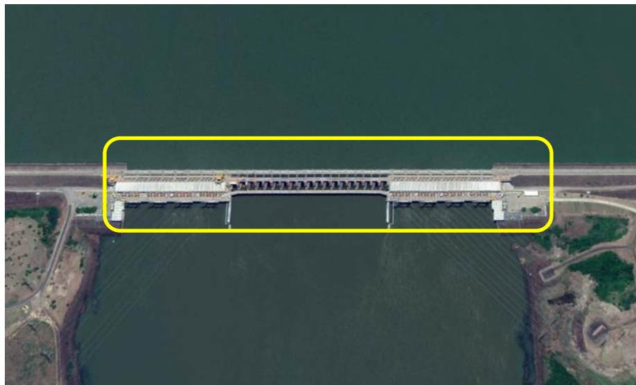
Los elementos de elevación están localizados en ambas centrales
