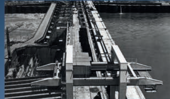
El Puente Internacional que corona la Represa de Salto Grande y los Puentes de servicio, son vías de circulación que se extienden sobre los diques laterales y cruzan la estructura de la central y vertedero mediante puentes de hormigón armado.
