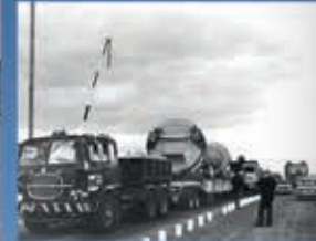
Gran parte del equipamiento electromecánico para la central fue recibido en el puerto de Salto, proveniente de diferentes partes del mundo. Dadas las dimensiones de dicho equipamiento fue necesario montar grúas especiales para su descarga.
