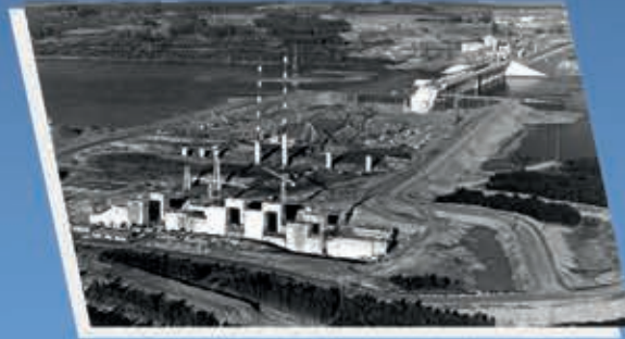
Doa salas de máquinas cubiertas, iguales y simétricamente ubicadas a cada lado del vertedero, que alojan 7 unidades hidrogeneradores tipo Kaplan de 135 MW, por unidad. Cada una de las salas con una longitud aproximada de 240 metros, incluye su sala de montaje, de comando y de servicios auxiliares.
