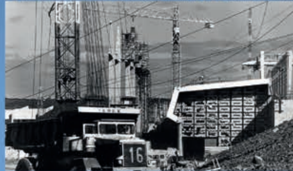
Doa salas de máquinas cubiertas, iguales y simétricamente ubicadas a cada lado del vertedero, que alojan 7 unidades hidrogeneradores tipo Kaplan de 135 MW, por unidad. Cada una de las salas con una longitud aproximada de 240 metros, incluye su sala de montaje, de comando y de servicios auxiliares.
