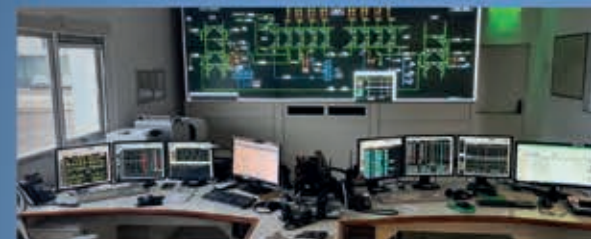
Suministro e instalación video wall Centro Operación (COU)
