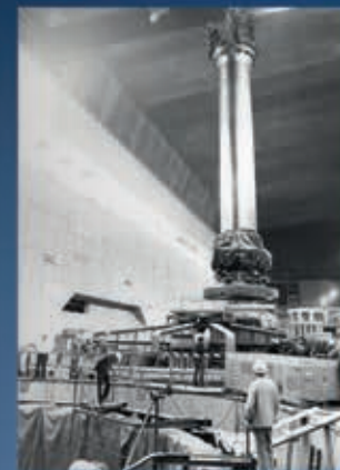
La central cuenta con 14 turbinas, cada una de 8,5 metros de diámetro y permite el paso de 600 metros cúbicos de agua por segundo.
