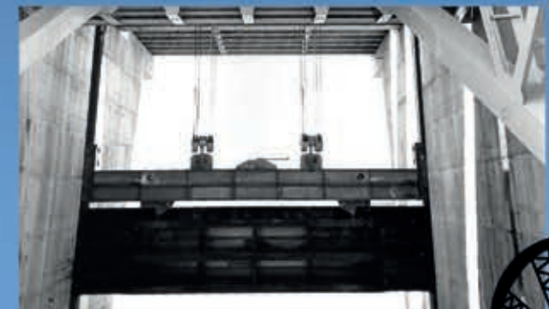
El vertedero de la central está constituido por 19 compuertas radiales ubicadas en forma simétrica respecto del eje del Río Uruguay. Las compuertas son accionadas por servomotores hidráulicos.
