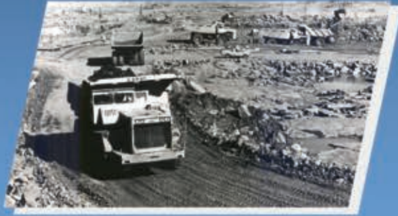
La empresa constructora Salto Grande S.A. adquirió para sus trabajos en las gigantescas obras de Salto Grande, poderosísimos equipos Terex 33-65, volquetes de descarga para 70 toneladas.
