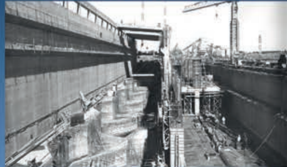
Doa salas de máquinas cubiertas, iguales y simétricamente ubicadas a cada lado del vertedero, que alojan 7 unidades hidrogeneradores tipo Kaplan de 135 MW, por unidad. Cada una de las salas con una longitud aproximada de 240 metros, incluye su sala de montaje, de comando y de servicios auxiliares.
