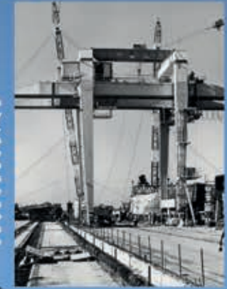
El diseño de las grúas contempló las necesidades específicas de la obra y las condiciones climáticas del lugar. El complejo cuenta con dos grúas pórtico ubicadas en el puente de servicio aguas arriba utilizadas para accionar rejas y compuertas verticales de los descargadores de fondo y dos grúas pórtico ubicadas en el puente de servicio aguas abajo para el manejo de tableros auxiliares de cierre de los tubos de aspiración y descargadores.
