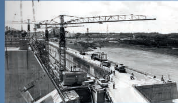
El Puente Internacional que corona la Represa de Salto Grande y los Puentes de servicio, son vías de circulación que se extienden sobre los diques laterales y cruzan la estructura de la central y vertedero mediante puentes de hormigón armado.
