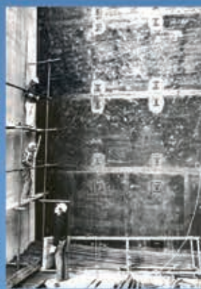
Las compuertas planas de toma efectúan el corte del agua con la turbina en funcionamiento, es un dispositivo de seguridad y las compuertas planas del vertedero son utilizadas como cierres de emergencia durante su operación.
