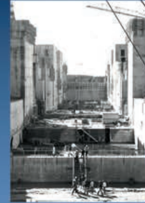
Estructura de hormigón armado ubicada en la margen argentina del río y que forma parte de la presa. Tiene una longitud de 135 metros y un ancho libre de 25 metros.
