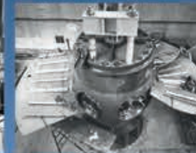
La central cuenta con 14 turbinas, cada una de 8,5 metros de diámetro y permite el paso de 600 metros cúbicos de agua por segundo.
