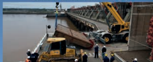
Servicio de mantenimiento compuertas y vertederos
