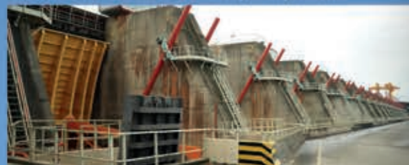
Pintado de compuertas radiales de vertedero
