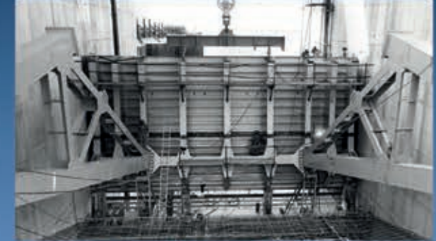
El vertedero de la central está constituido por 19 compuertas radiales ubicadas en forma simétrica respecto del eje del Río Uruguay. Las compuertas son accionadas por servomotores hidráulicos.
