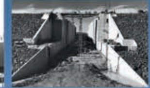
Estructura de hormigón armado ubicada en la margen argentina del río y que forma parte de la presa. Tiene una longitud de 135 metros y un ancho libre de 25 metros.
